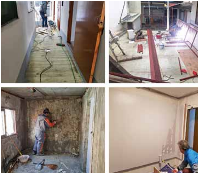
바닥 공사, 철재 난간공사, 벽체 시멘트공사로 공간의 재탄생
