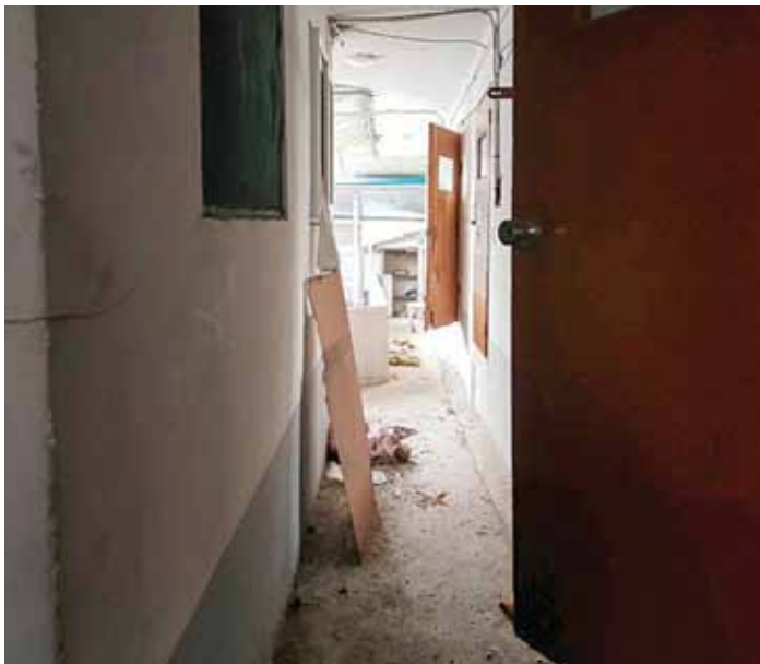
2층 노송늬우스박물관 13개 방 조성 공사
